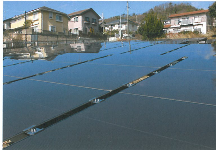
20年保障が間違いないものを徹底して選んだ、強化ガラスや緩まないボルトを使ったソーラーパネル
