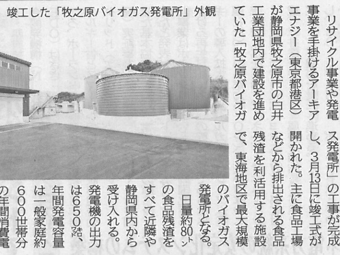
竣工した「牧之原バイオガス発電所」外観
